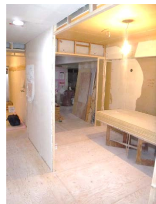
※画像は、施工中の様子です。
